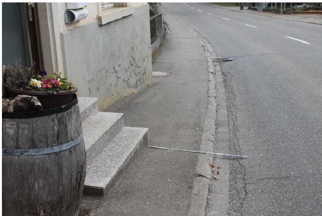
Abbildung 2: Engstelle Gehweg 0,60 m
