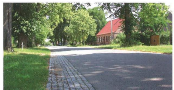
„Weiche Separation“ zwischen Fahrbahn und Seitenraum
