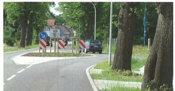
Geschwindigkeitsdämpfung im Ortseinfahrtbereich durch Mittelinsel mit deutlichem Fahrbahnversatz
