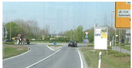
Geschwindigkeitsdämpfung im Ortseinfahrtbereich durch Kreisverkehr
