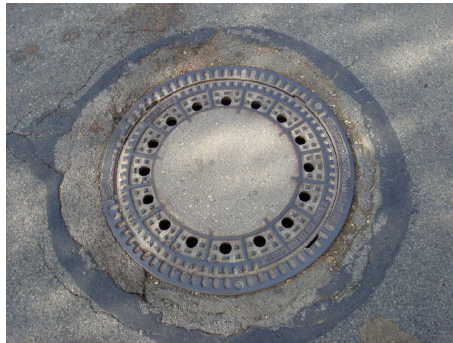
Abb.1 schadhafte Gullideckel
